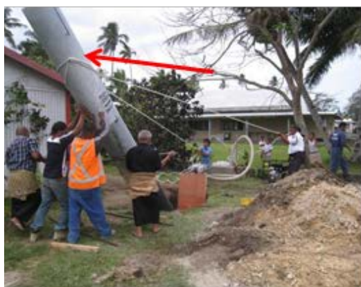
(写真5) 現地メンバーによるアンテナ建柱作業風景
